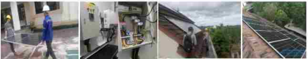
Pemasangan PLTS Atap di Gedung DPMPSTP dan DINKES Provinsi Banten
