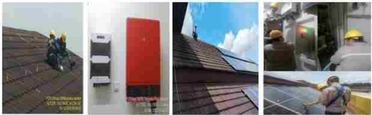
Pemasangan PLTS Atap di Gedung SKPD Terpadu dan BKD Provinsi Banten.
